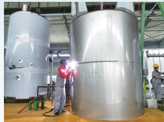
■车间工作人员正在焊接罐体
